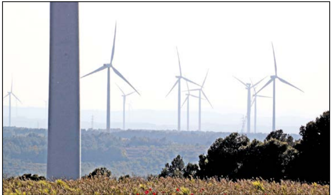
Imatge d'arxiu d'un parc eòlic de la Terra Alta. // ACN.
