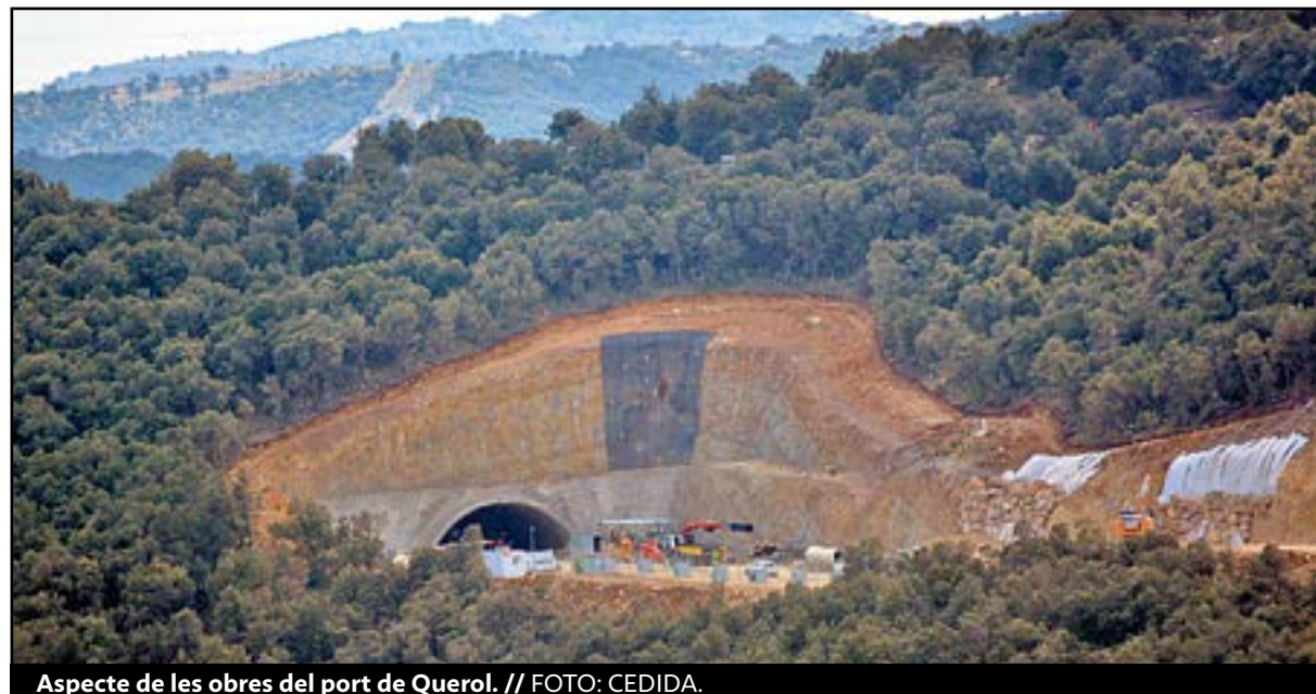
Aspecte de les obres del port de Querol. // FOTO: CEDIDA.
